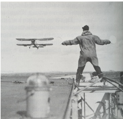
( Op deze afbeelding zijn de kabels zichtbaar waarmee het vliegtuig werd afgeremd.)
